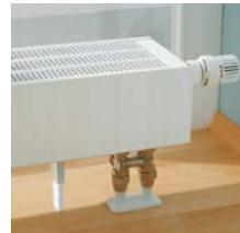
Встроенная вентильная группа оптимальна не только в энергосбережении и внешней эстетике. Отсутствие подающего и обратного трубопроводов рядом с конвектором также значительно экономит время монтажа.
